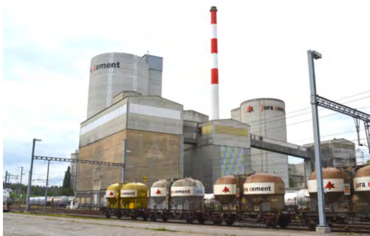
Das Zementwerk Wildegg (AG) von Jura Cement hat 2017 an 172 Tagen – also an fast jedem zweiten Tag – zu viel krebserzeugendes Benzol in die Luft geblasen. Foto: AefU
