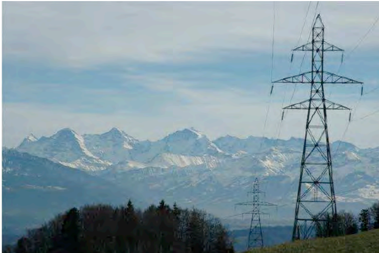
La ligne à haute tension Wattenwil-Mühleberg de 132kV sur le Längenberg (commune de Rüeggisberg BE). Elle devait passer à 230kV. Les mâts auraient dû être deux fois plus hauts. Après que le Tribunal fédéral a décidé de planifier une mise sous terre pour 23 km des 33km, BKW et Swissgrid ont provisoirement gelé le projet.
