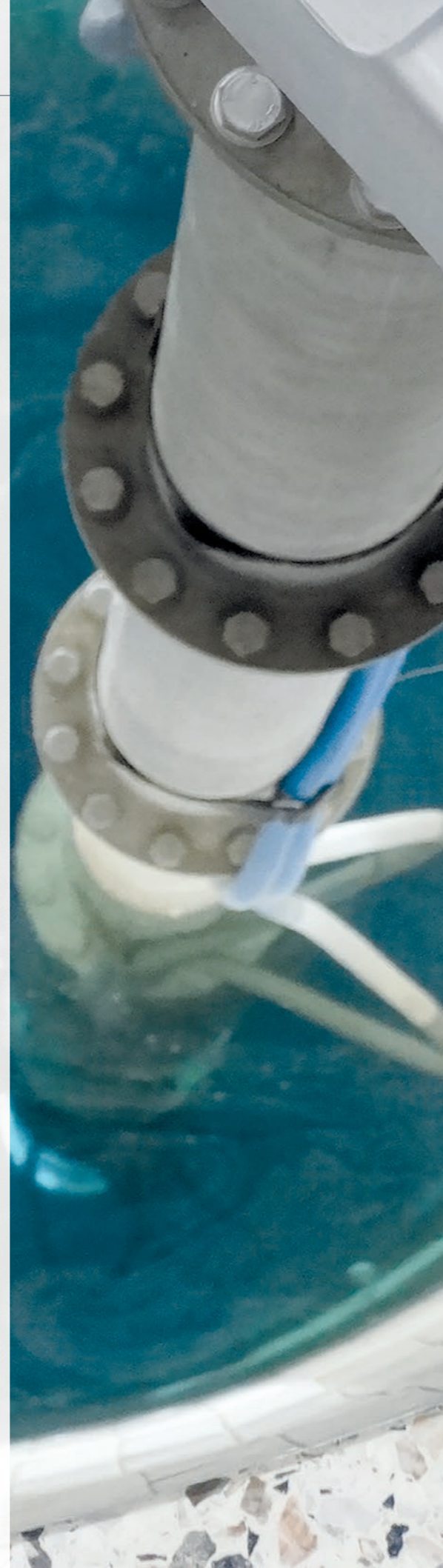
Vertikaler Trinkwasserbrunnen mit Steigleitung. © SVGW
