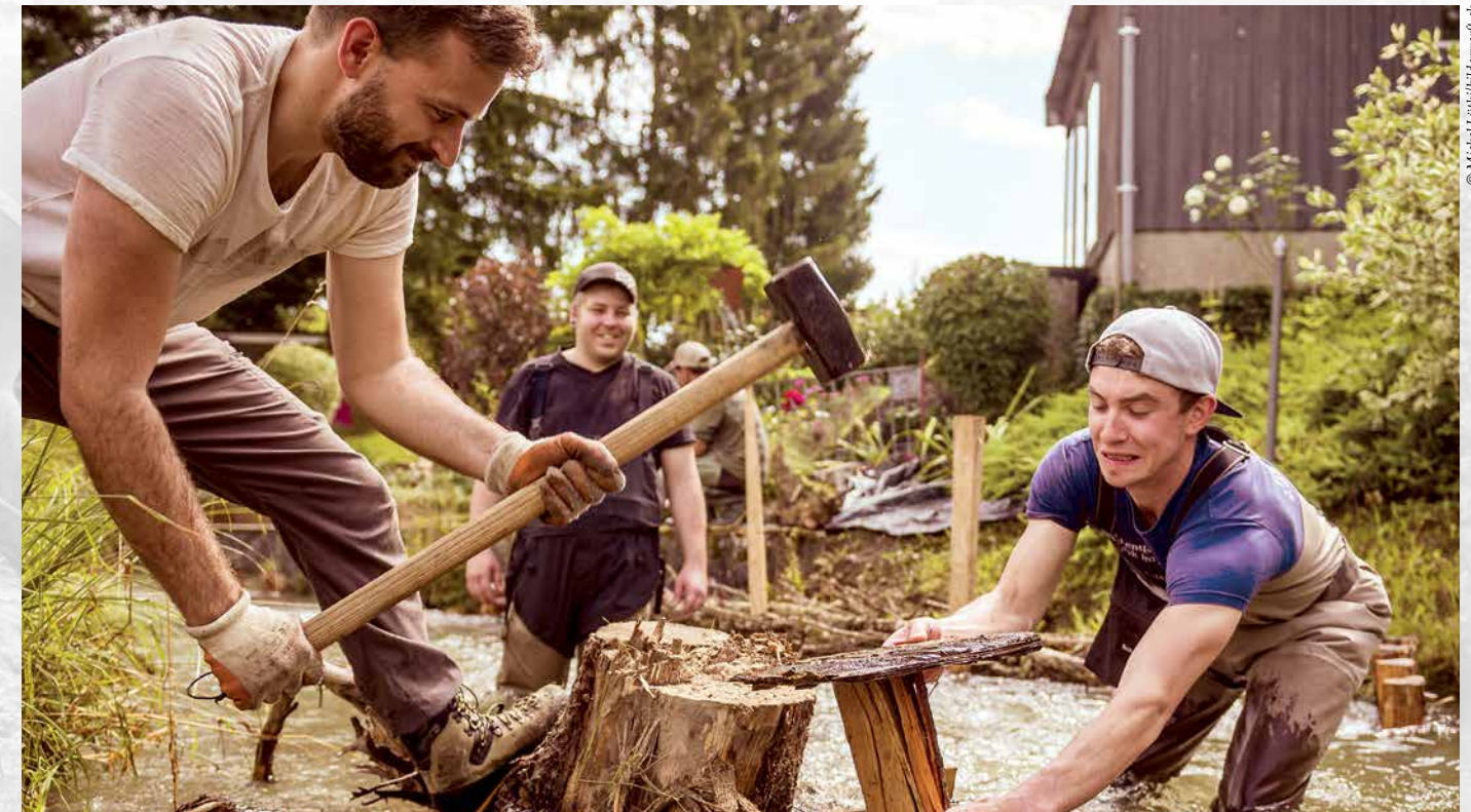
Les associations de pêche installent des structures dans la rivière. Le rhizome placé ici crée de la dynamique, du biotope et des abris pour les poissons.
