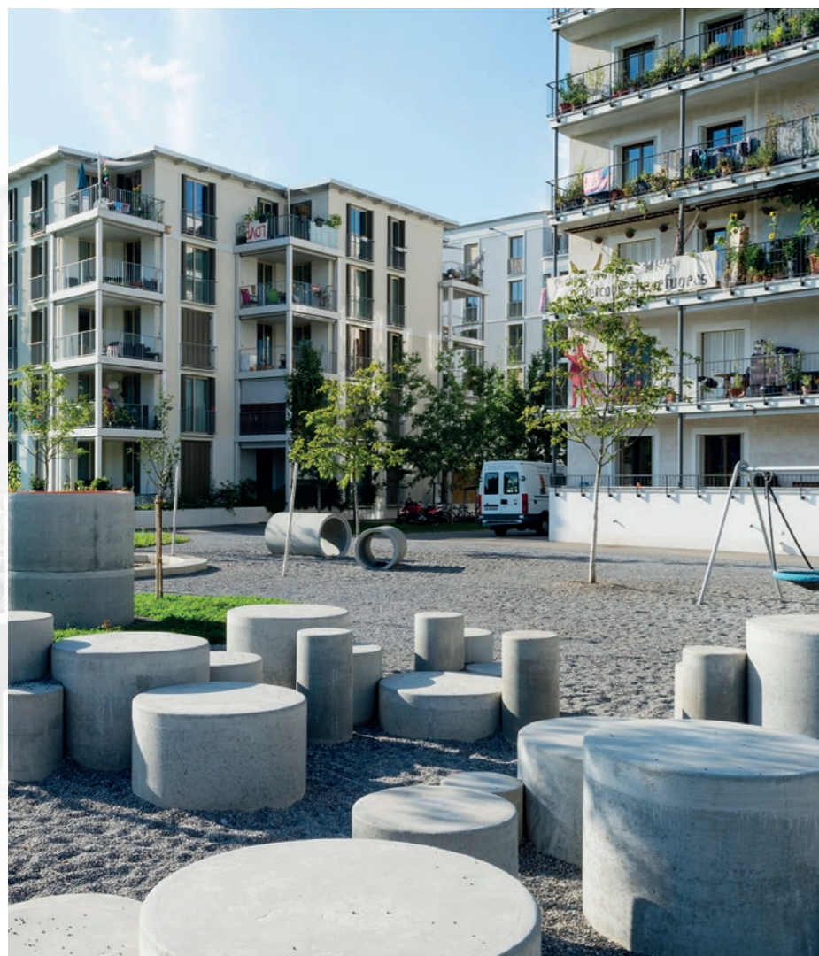
Aire de jeux du Hunziker Areal/Zurich (coopérative de construction mehr als wohnen).
