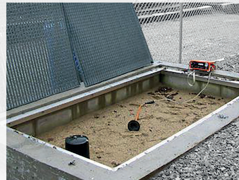
Le sable et le compost situés dans ce filtre éliminent 95% du gaz méthane capté du sol bâti.
