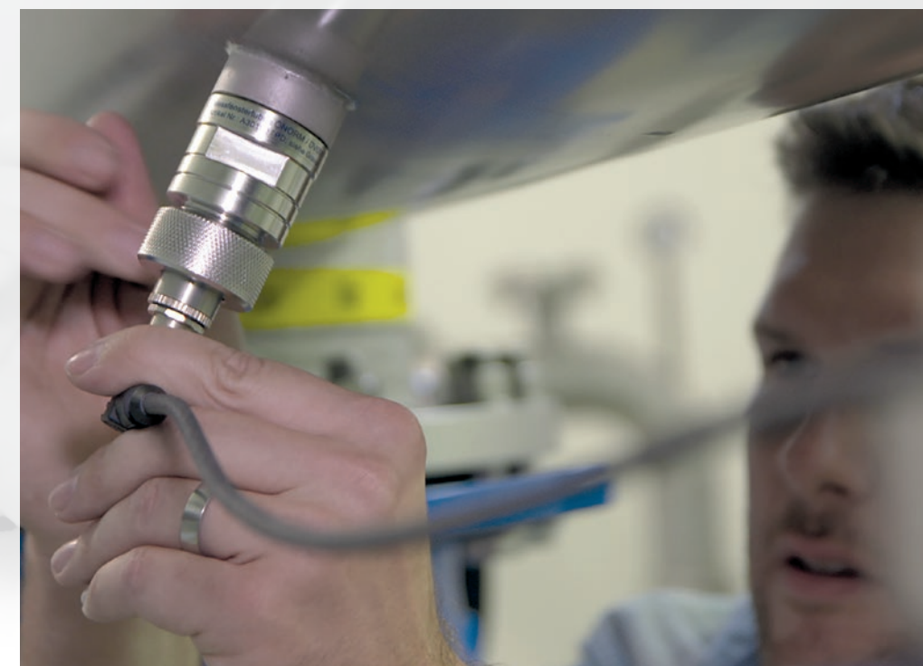
Contrôle de l'installation UV dans le traitement de l'eau potable. © SVGW
