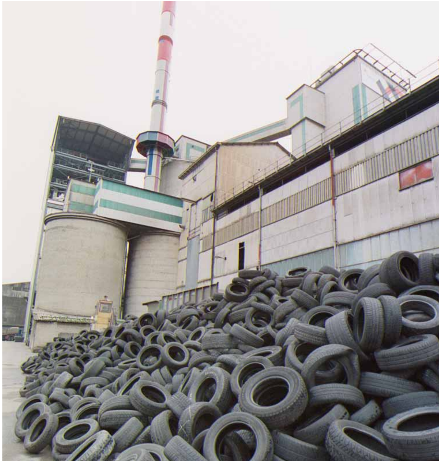
Pneus als Brennstoff beim Zementwerk Siggenthal AG in Wuerenlingen. Keystone
