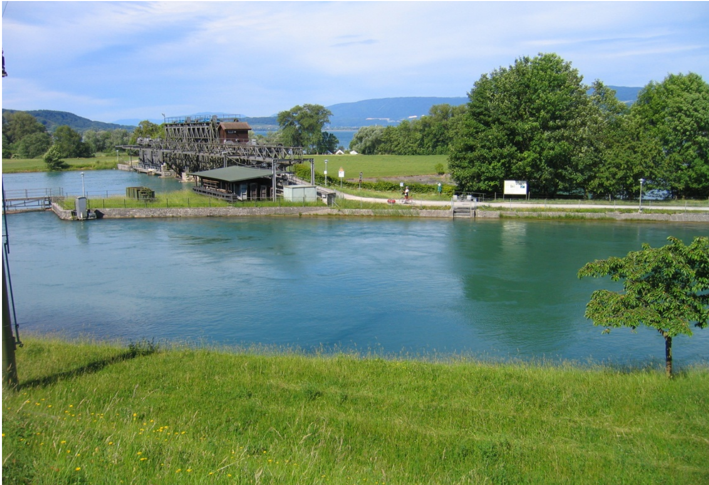
Stauwehr zwischen Aare/Hagneckkanal und Bielersee
