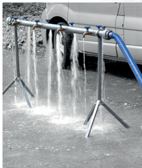
Ici, de l'eau potable d'urgence serait distribuée.
