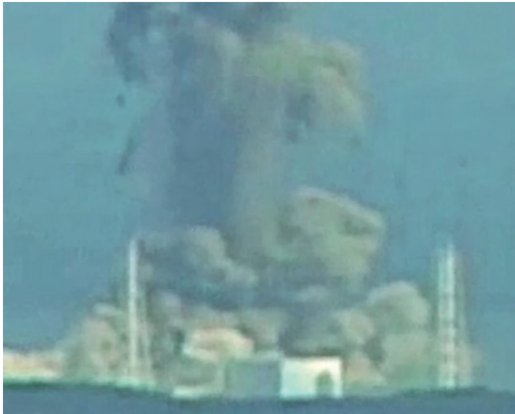
Explosion à la centrale nucléaire de Fukushima en 2011.
