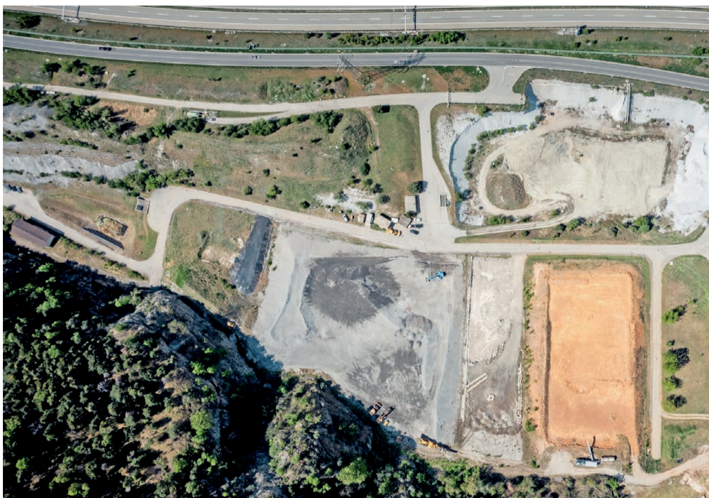
Aus der Luft: Die Sanierung der Deponie Gamsenried wird bald in Angriff genommen. Wie lange die Arbeiten dauern, ist noch unklar.
