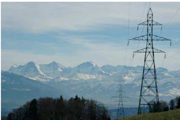
Auf dem Längenberg (Gemeinde Rüeggisberg BE) die Hochspannungsleitung 132kV Wattenwil-Mühleberg. Sie sollte auf 230kV hochgerüstet werden. Die Masten wären dann doppelt so hoch geworden. Nach dem das Bundesgericht entschieden hat, dass für 23 von 33km eine Erdverlegung zu planen sei, haben BKW und Swissgrid das Projekt vorläufig auf Eis gelegt. Foto: Ursula Ohnewein
