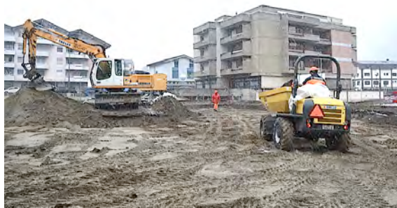
Ende 2017 haben die ersten grossflächigen Sanierungsarbeiten der Quecksilber-Gärten der Lonza AG in Raron (VS) endlich begonnen: Rund um die Häuser bei der Bahnhostrasse lässt die Lonza AG den kontaminierten Boden abtragen. Fotos: AefU
