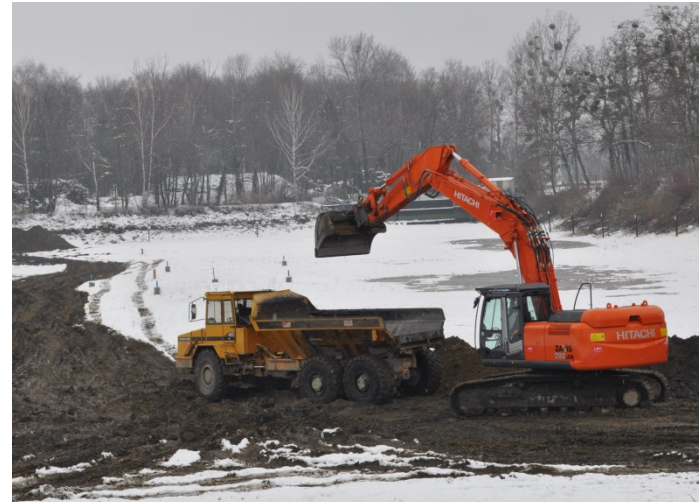
Klärteich, Ausbaggerung, Winter 2013 (Foto: CIMO)
