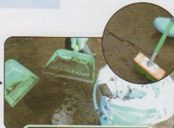
土砂等の除去（外側から内側へ）
