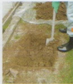
除染した場所からかぶせるための土を調達
