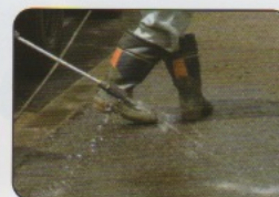
高圧水洗浄では、最初は通常の水圧で排水溝までの水の流れを確認。
