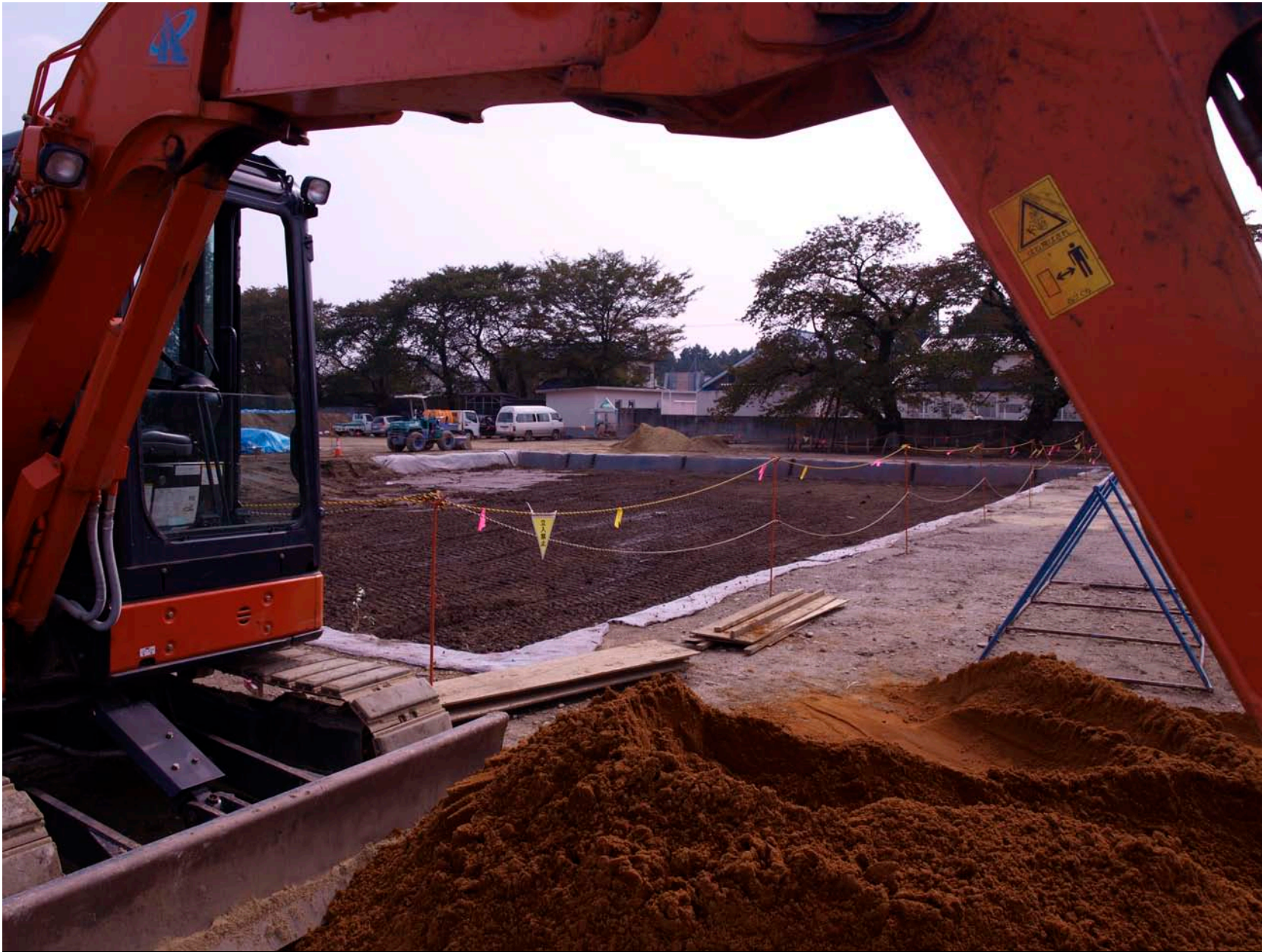
Dekontaminierung eines Schulhofs, Minami-Soma
