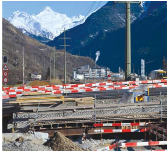
Bis in die 1970er-Jahre via Abwasser «entsorgt», taucht das Quecksilber des Lonza-Werks Visp (im Hintergrund) bei der A9-Baustelle wieder auf.
