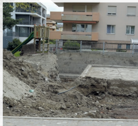
Sanierung eines mit Quecksilber belasteten Kinderspielfeldes in Visp (VS) durch die Verursacherin Lonza, im April 2017. © OEKOSKOP
