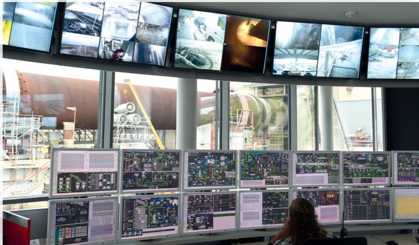
Hightech pur: Die Steuerzentrale des Zementwerks Allmendingen (D) mit Blick auf den Drehrohrofen. Ein Mitarbeiter überwacht alles, auch die Einhaltung der Abgaswerte.
