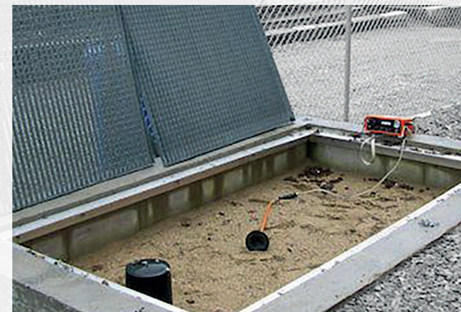
Sand und Kompost in diesem Filter eliminieren 95% des abgesaugten Methangases aus dem überbauten Boden. © zvg
