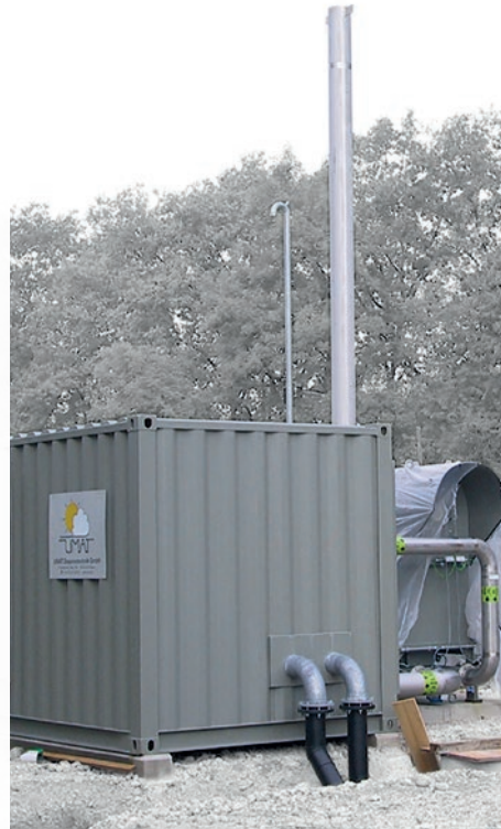
Aufbereitungsanlage für Methangas, das in Kohlendioxid und Wasser gespalten wird.
