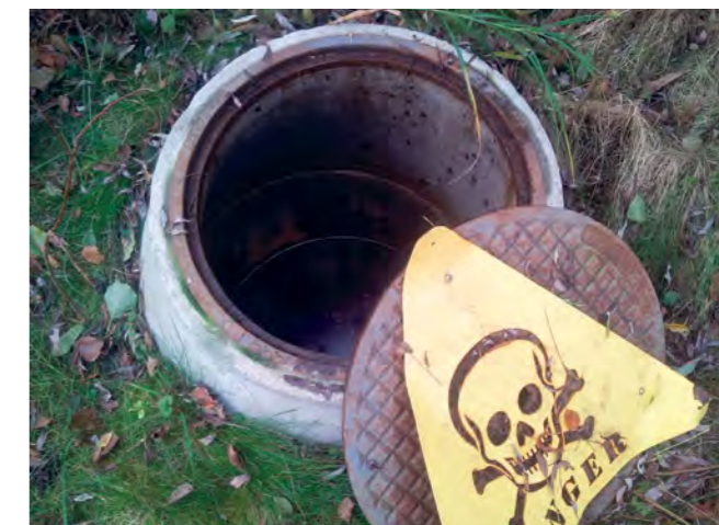
Collecteur de lixiviats pour le prélèvement d'échantillons dans le cadre des analyses concernant la décharge d'ordures ménagères.
