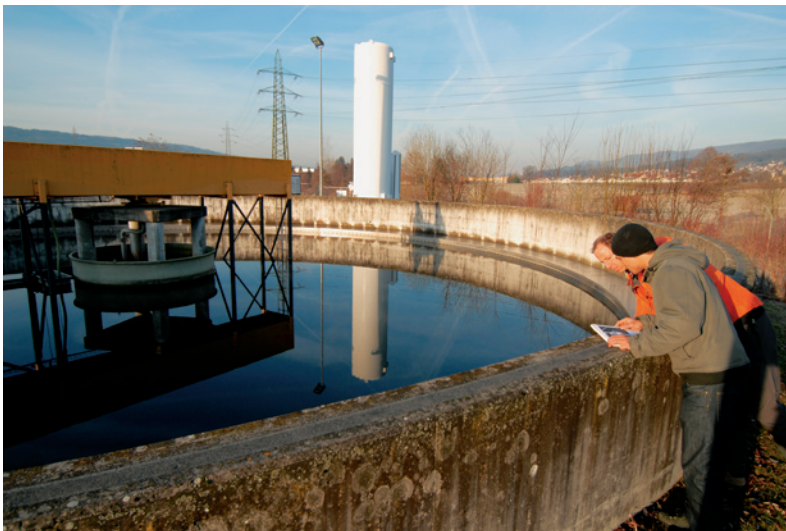
ARA Regensdorf: Im Hintergrund der Tank mit dem Flüssigsauerstoff zur Ozonproduktion.
