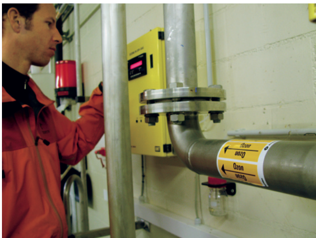
Die Ozonierung des bereits gereinigten Abwassers kann 90 % der verbliebenen Toxizität reduzieren.
