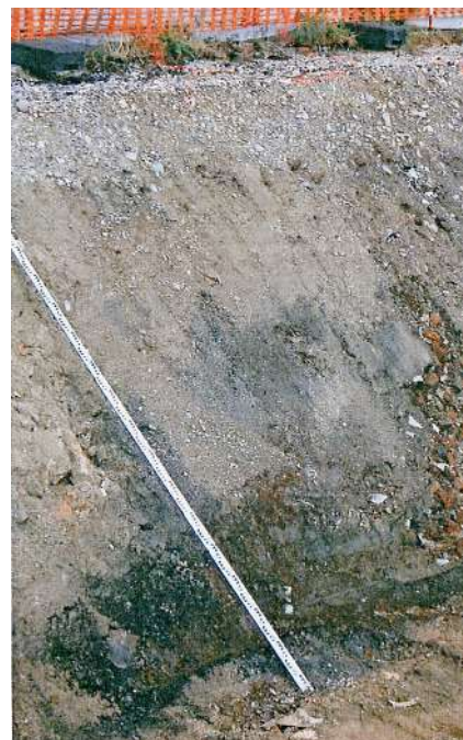
Giftiger Aushub. Die schwarzen Flecken sind «Chemieschlamm» auf einer Baustelle im Klybeck.
