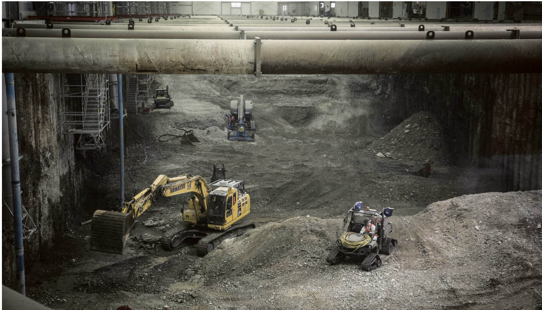
Die Arbeiten in der Kesslergrube finden unter strengsten Sicherheitsbestimmungen statt; Aussenstehende dürfen nicht hinein, die Arbeiter sind mit Schutzkleidung und externer Atemluft versorgt. Foto: Kostas Maros
