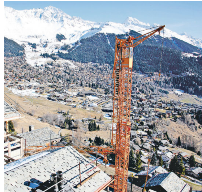
Bauordnung missachtet. Obwohl die Projekte von der Gemeinde wie auch vom Kanton genehmigt worden sind. ARCHIVBILD KEYSTONE
