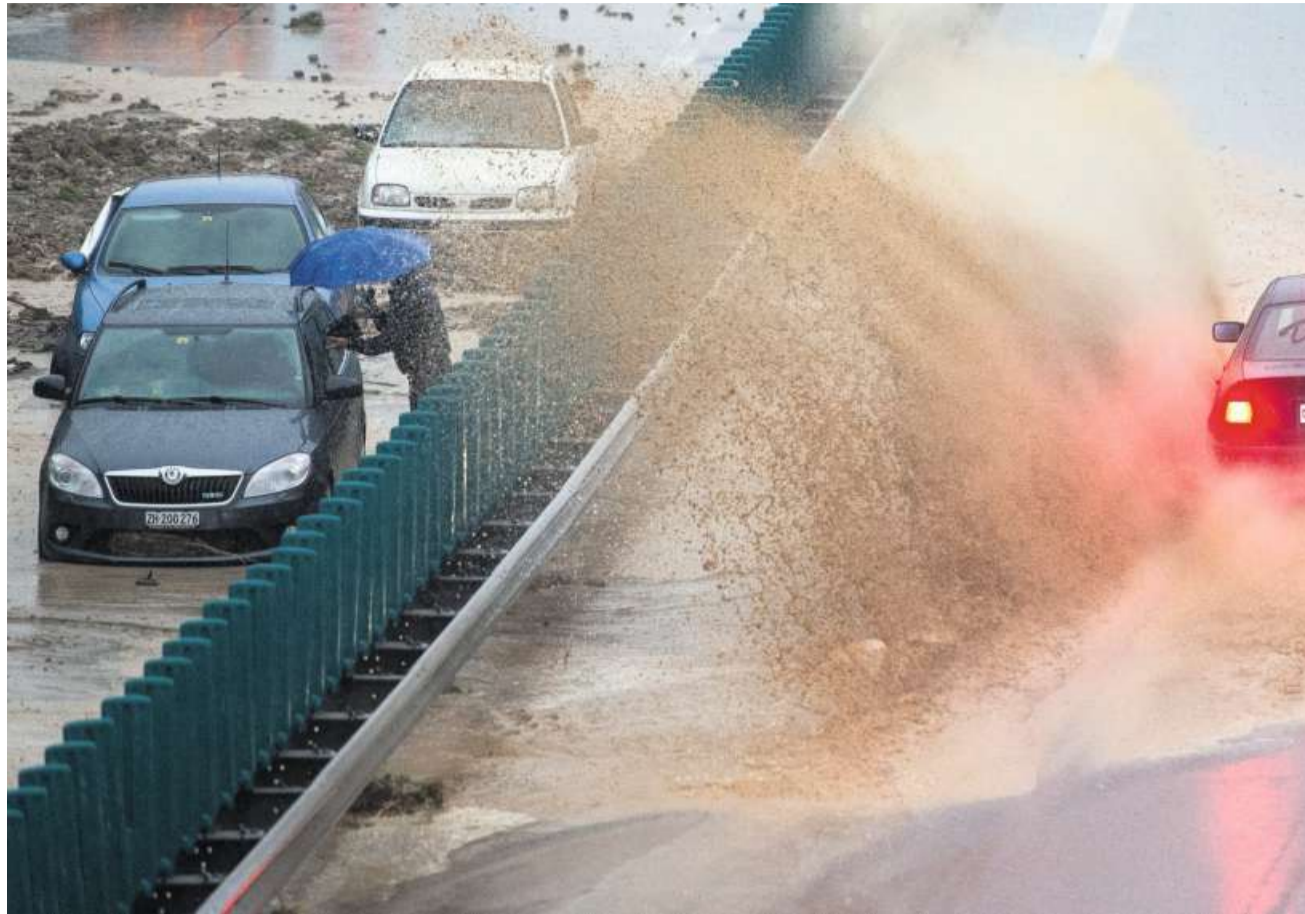
Nach heftigen Gewittern waren viele Strassen überschwemmt, darunter auch die Autobahn 1 in Wil.
