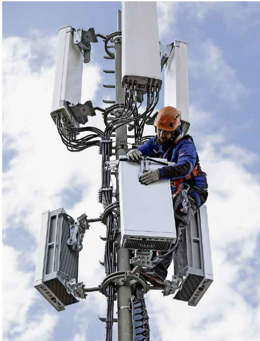
Arbeiter bei der Montage einer 5G-Antenne in Bern.
