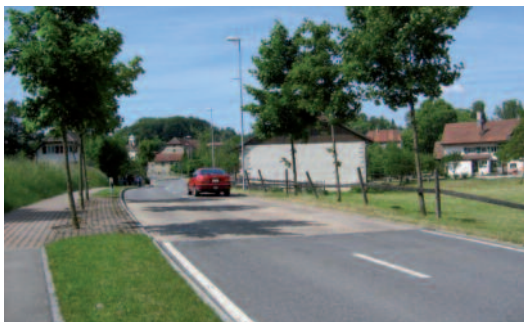
Trennstreifen zur Fahrbahn.
