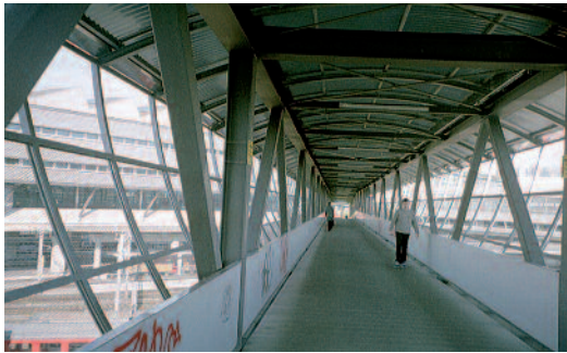
Überdachte Bereiche, punktueller Witterungsschutz.
