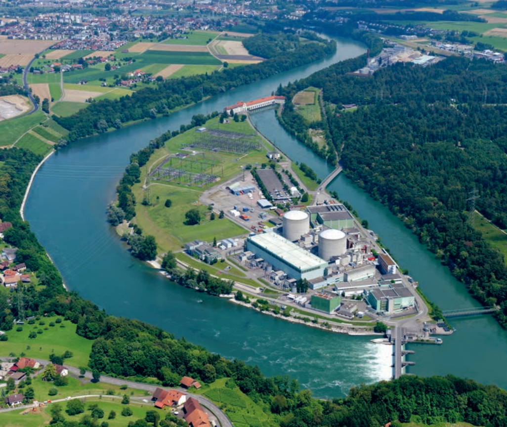
Keines der Schweizer Atomkraftwerke hält baulich gegen schwere militärische Angriffe Stand. Im Bild AKW Beznau, das weltweit älteste in Betrieb (seit 1969).
