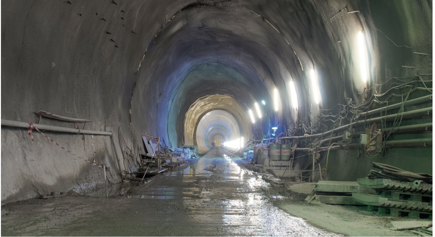
Der Spritzbeton beim Bau des Ceneri-Basistunnels enthielt PFAS. Im Bild die Oströhre 2015, seit 2020 in Betrieb.
