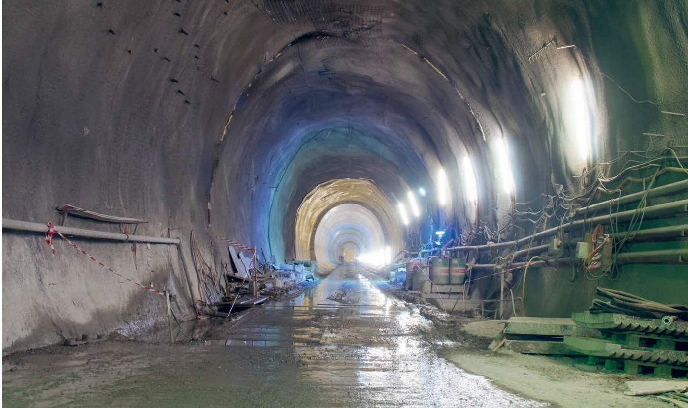
Le béton projeté lors de la construction du tunnel de base de Ceneri contenait des PFAS. Sur la photo, le tube Est en 2015.
