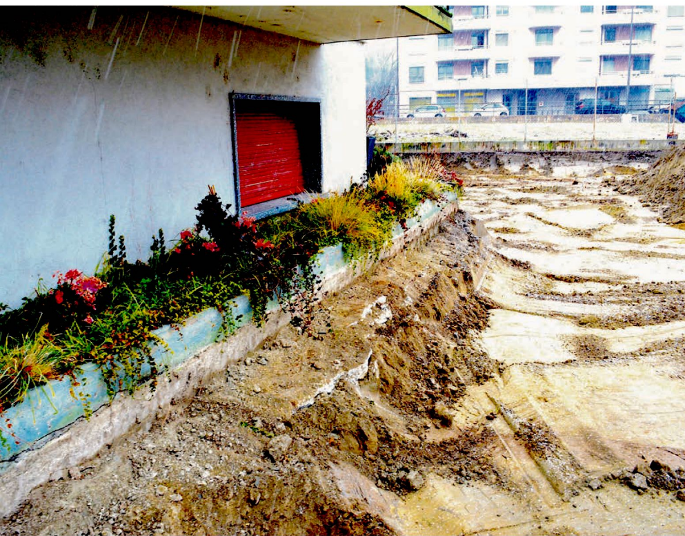
Quecksilberverschmutztes Wohnquartier in Raron VS. Sanierungsarbeiten der Lonza bis an die Hausmauer, 2017.
