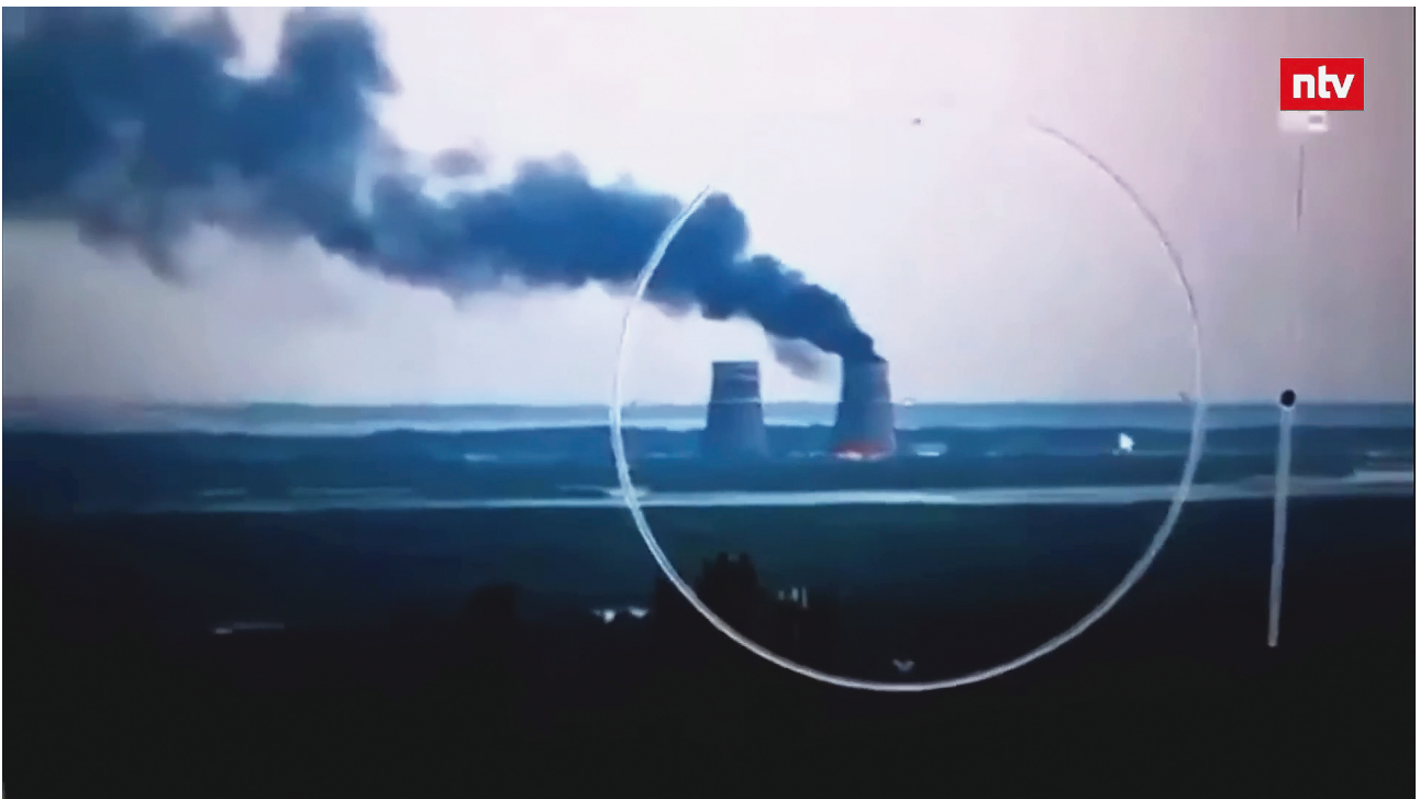
Brand im Kühlturm beim abgeschalteten AKW Saporischschja im Süden der Ukraine, nahe Nikopol im August 2024. Nach ukrainischen Angaben sollen russische Truppen das Feuer gelegt haben. Foto: Screenshot ntv Nachrichten. Foto: Beat W. Hohman
