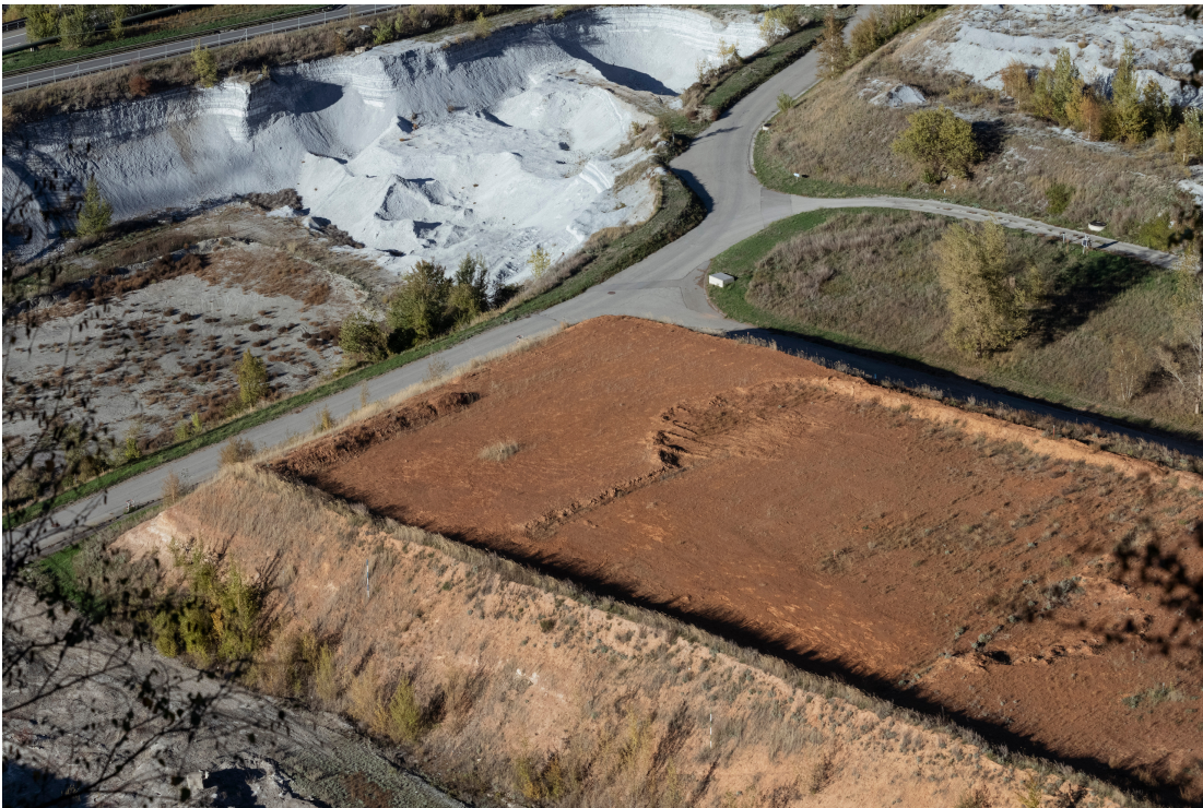
Die Sondermülldeponie Gamsenried des Pharmakonzerns Lonza bei Brig (VS): Die Sanierung dürfte rund 1 Milliarde Franken kosten. Foto: AefU/WWF
