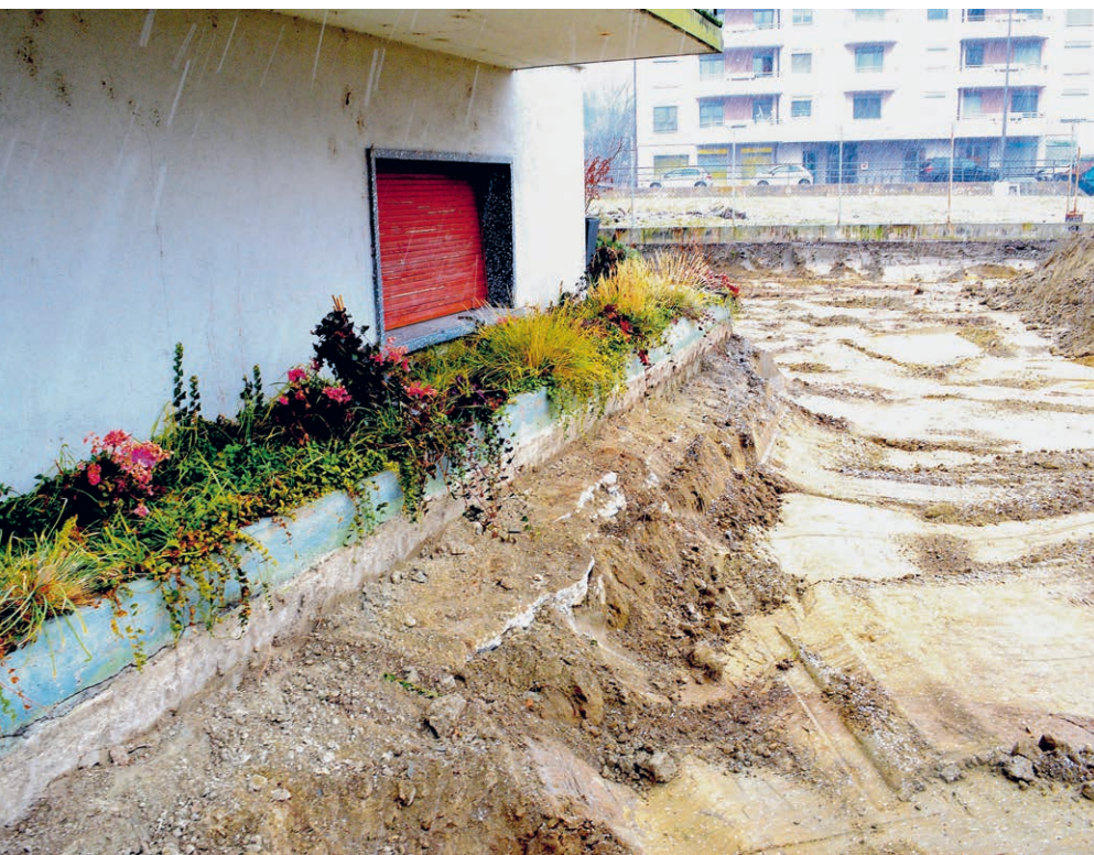
Quecksilberschmutztes Wohnquartier in Raron VS. Sanierungsarbeiten der Lonza bis an die Hausmauer, 2017.
